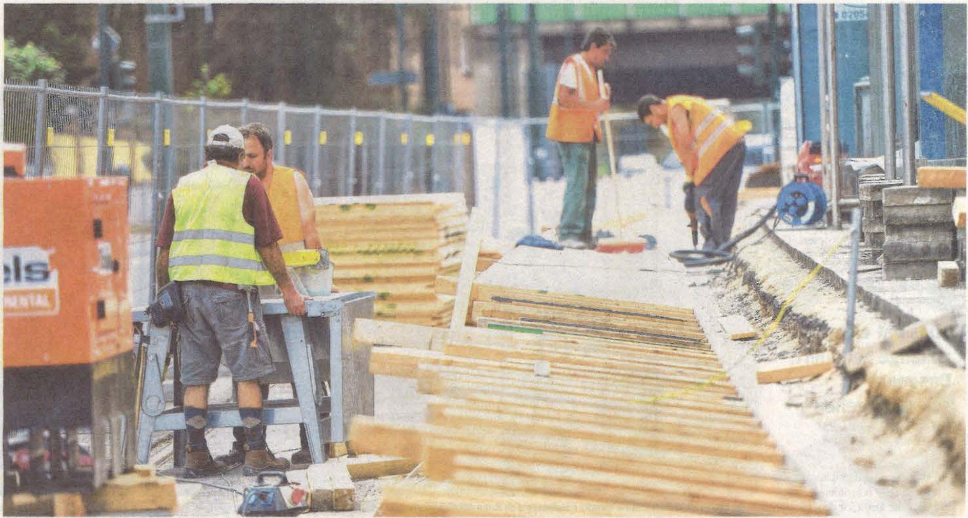
Blick auf die Baustelle an der U-Bahn-Haltestelle Heßlerstraße. Für rund 400.000 Euro werden an fünf Stationen die Bahnsteige erneuert.
