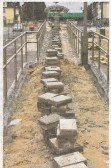
An der Heßlerstraße sind die Abbrucharbeiten abgeschlossen. FOTO: KONOPKA
